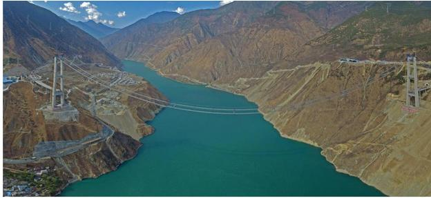
4 月 5 日，四川甘孜藏族自治州泸定县，建设中的雅康高速泸定大渡河兴康特大桥，桥面施工便道——“猫道”已经架设完成，工作人员正在架设首根主缆索股。被誉为“川藏第一桥”的雅
