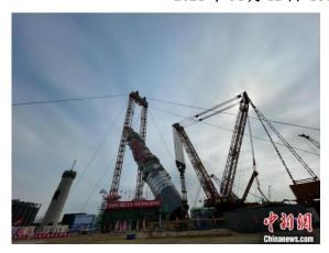
中新网揭阳 4月 17 日电(记者 方 伟彬)起吊重量达 4606 吨的抽余液塔 17 日在广东揭阳成功吊装,该塔的就 位刷新了亚洲最重塔器吊装纪录。
